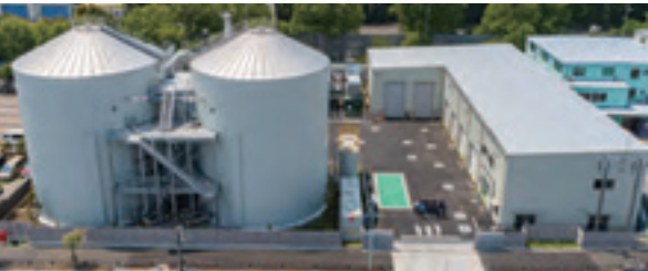
西東京リサイクルセンター
